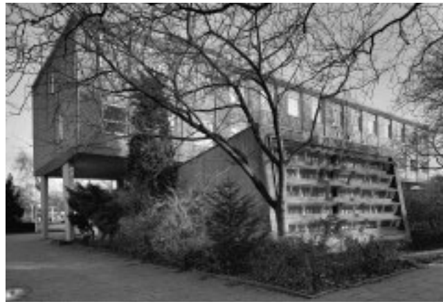
2 Beckum-Neubeckum, Rathaus, Ansicht von Nordwesten, im Vordergrund der Ratssaal. 2005.
