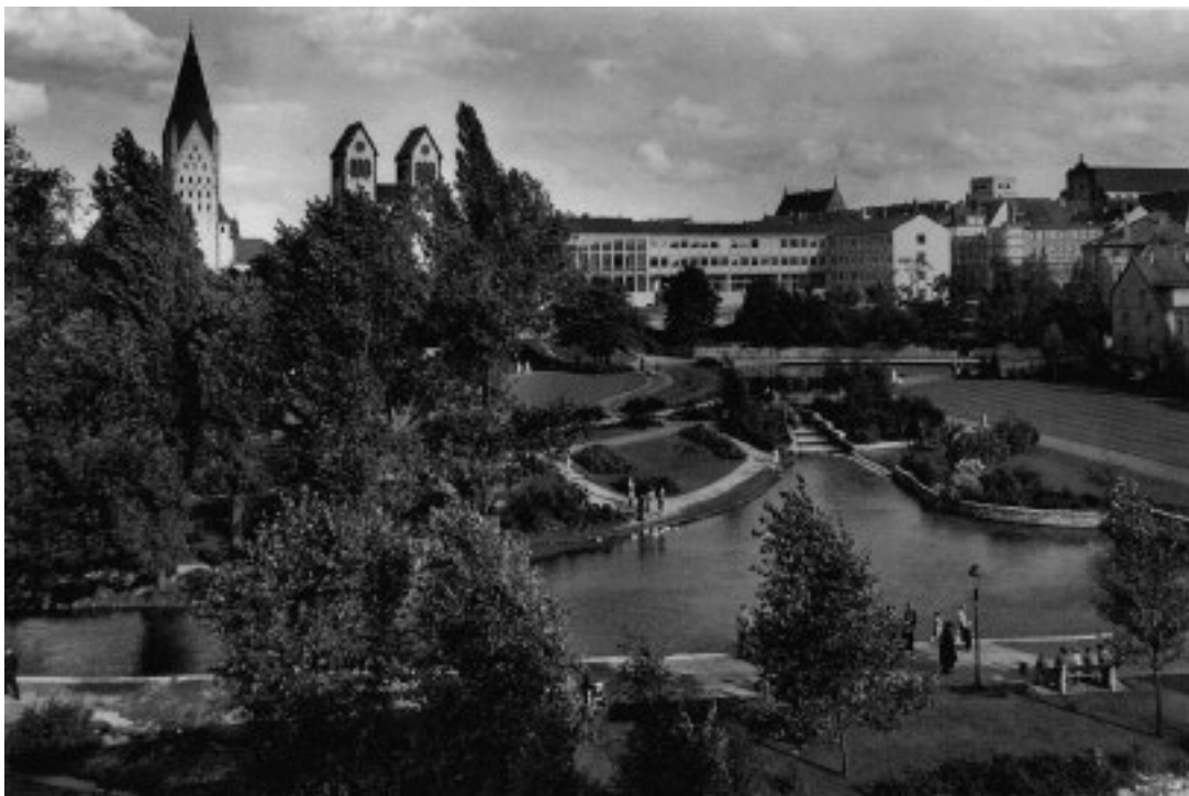
3 Die neugestaltete Grünanlage an den Paderquellen Mitte der 1950er Jahre, im Hintergrund das im Bau befindliche städtische Verwaltungsgebäude. 1950er Jahre.
