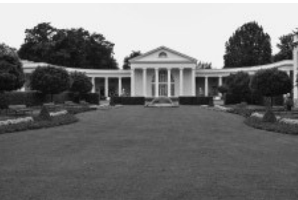
3 Wandelhalle am Tag der Wiederinbetriebnahme am 10.07.2008.
