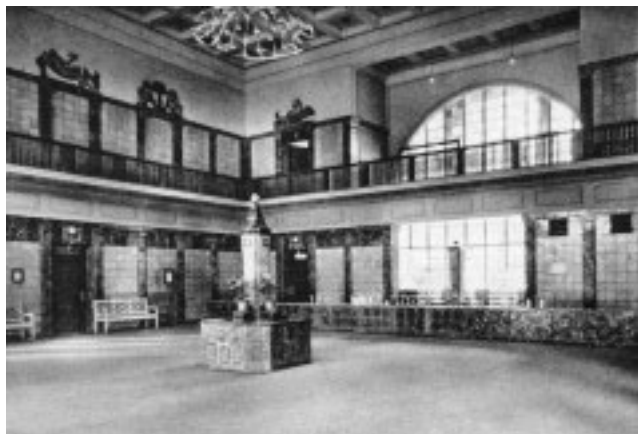
4 Wandelhalle in den 1920er/30er Jahren.
