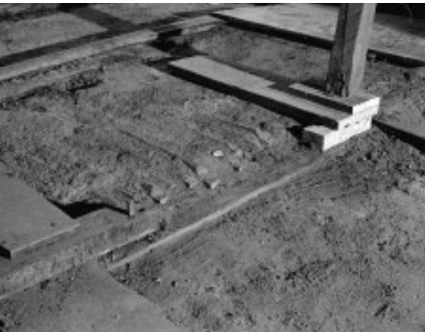
1 Aufgelegte freitragende Wellerhölzer im Dachboden. 2007.
