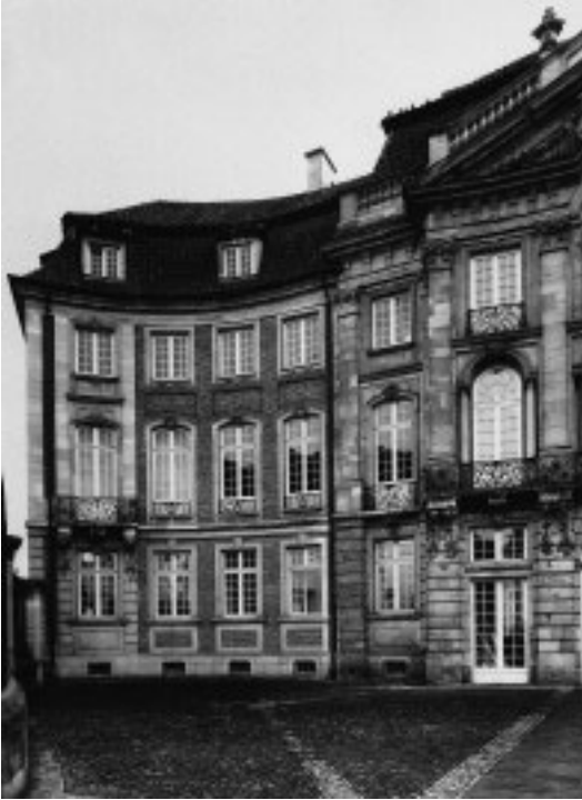
1 Erdrostenhof, Salzstrasse 38, Münster.
