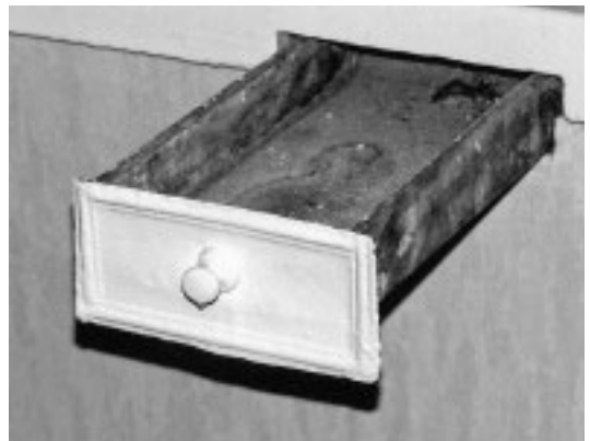
9 Schmallenberg-Obersorpe (Hochsauerlandkreis), Revierförsterei Rehsiepen von 1885, Detail: Das innenseitige Tauwasser der Fensterscheibe läuft in ein Gefäß, das als kleine Schublade entleert werden kann. 2008.
