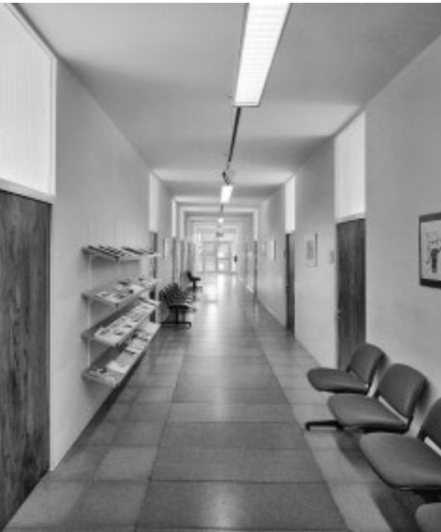
5 Beckum-Neubeckum, Rathaus, Flur im ersten Obergeschoss mit bauzeitlichen Türen und Abdeckung der Leitungen im Bodenbelag. 2005.
