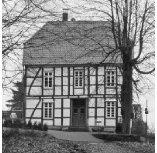
1 Horn-Bad Meinberg-Fissenknick (Kreis Lippe), Forsthaus des ausgehenden 18. Jahrhunderts. Im Obergeschoss des Wohntraktes, dessen Schauseite den sich rückwärtig anschließenden, dreischiffigen Wirtschaftsteil verdeckt, blieb der größte Raum dem Aufenthalt der Fürstenfamilie vorbehalten. 2007.
