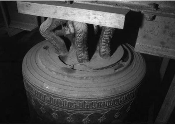
12 Große Glocke von 1466. Gussfehler im Plattenbereich.
