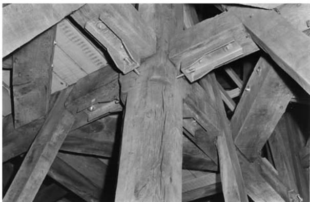
8 Der sanierte Anschlusspunkt des Mittelpfostens zur ersten Horizontalebene. 2005.
