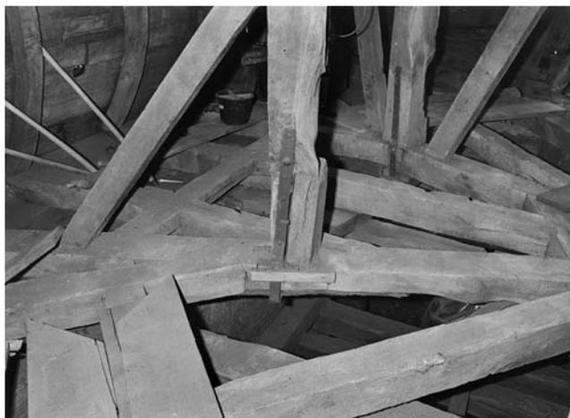
5 Sternbalkenlage mit Fußpunkten der Oktogonstützen. 2002.
