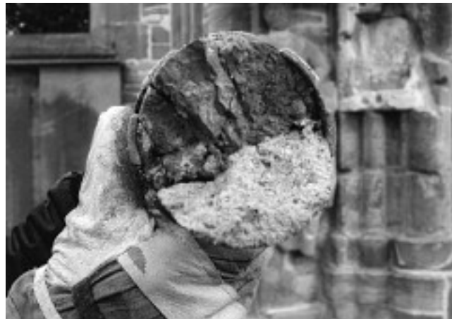
8 Bohrkernentnahme aus dem Ziegelpfeiler 2003.
