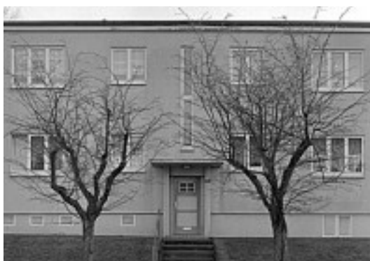
8 Hauseingangssituation mit erhaltenem Baumpaar, Haustyp C an der Hechelstrasse.
