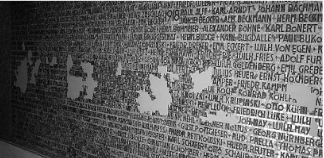
9 Schrifttafeln mit Restaurierung: Festigung der beschädigten Stellen, keine farbigen Ergänzungen. Zustand Dezember 2004.
