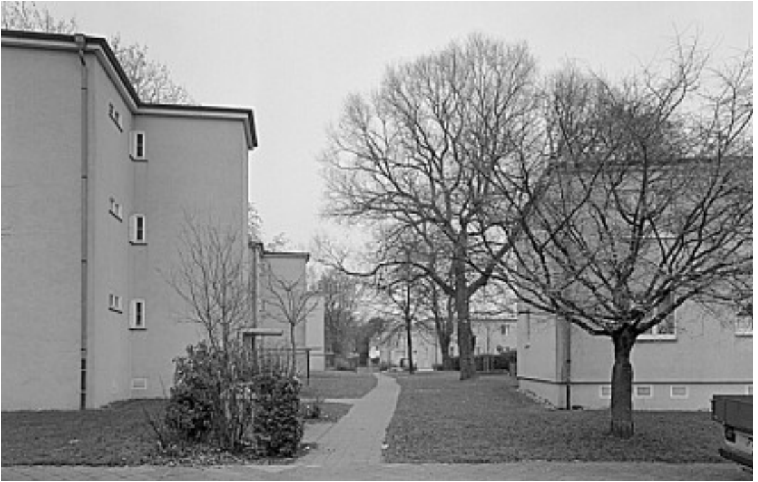
1 Fußweg von der Rockenstrasse südlich der Gebäude am Spinnstuhl, links Gebäudetyp B1 rechts Gebäudetyp C.
