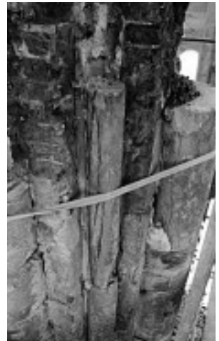
3 Freigelegter Ziegelkern des Bündelpfeilers 2003.
