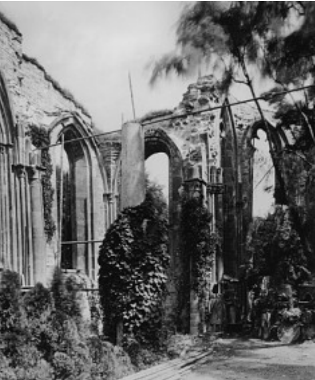
4 Der Bündelpfeiler nach der ersten Ruinensicherung im Jahr 1899.
