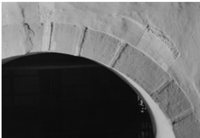
1 Willebadessen, kath. Pfarrkirche St. Vitus, südliches Seitenschiff, Arkadenbogen mit teilweise freigelegten Bandfugen.
