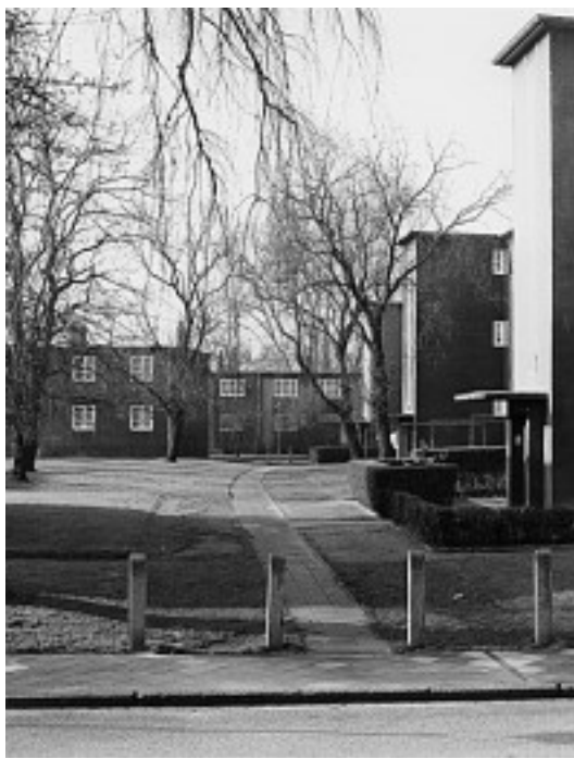
3 Fußweg von der Brakestrasse südlich der Gebäude am Spinnstuhl, links Gebäudetyp C rechts Gebäudetyp B1, jeweils mit noch ursprünglichen Fensterteilungen, Aufnahme 1975.
