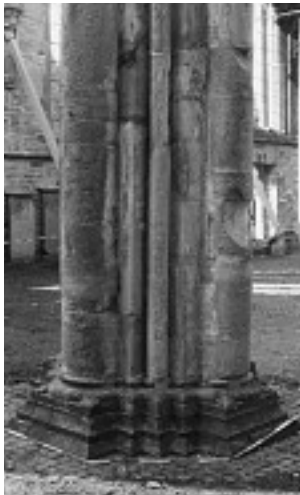
2 Nordöstlicher Bündelpfeiler vor der Restaurierung 2003.
