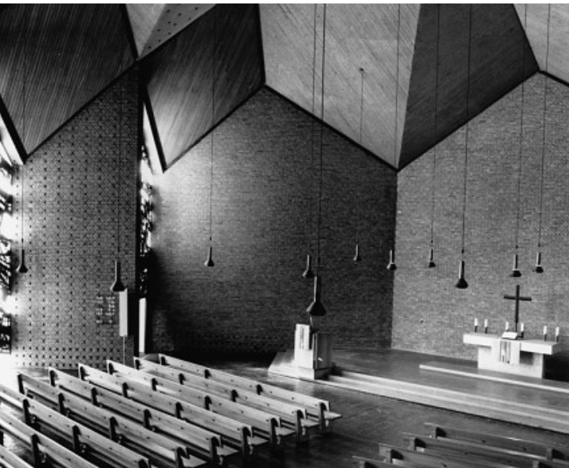
6 Christuskirche, stützenfreier Innenraum mit Betonfaltdache und Glasfenstern des Künstlers Helmut Lander.
