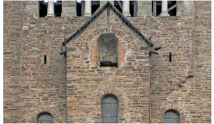
Abb. 927 Corvey, Westbau von Westen, Detail. Fugen zwischen den karolingischen Turmwänden und der ursprünglichen Westwand des Schlitzfenstergeschosses.
