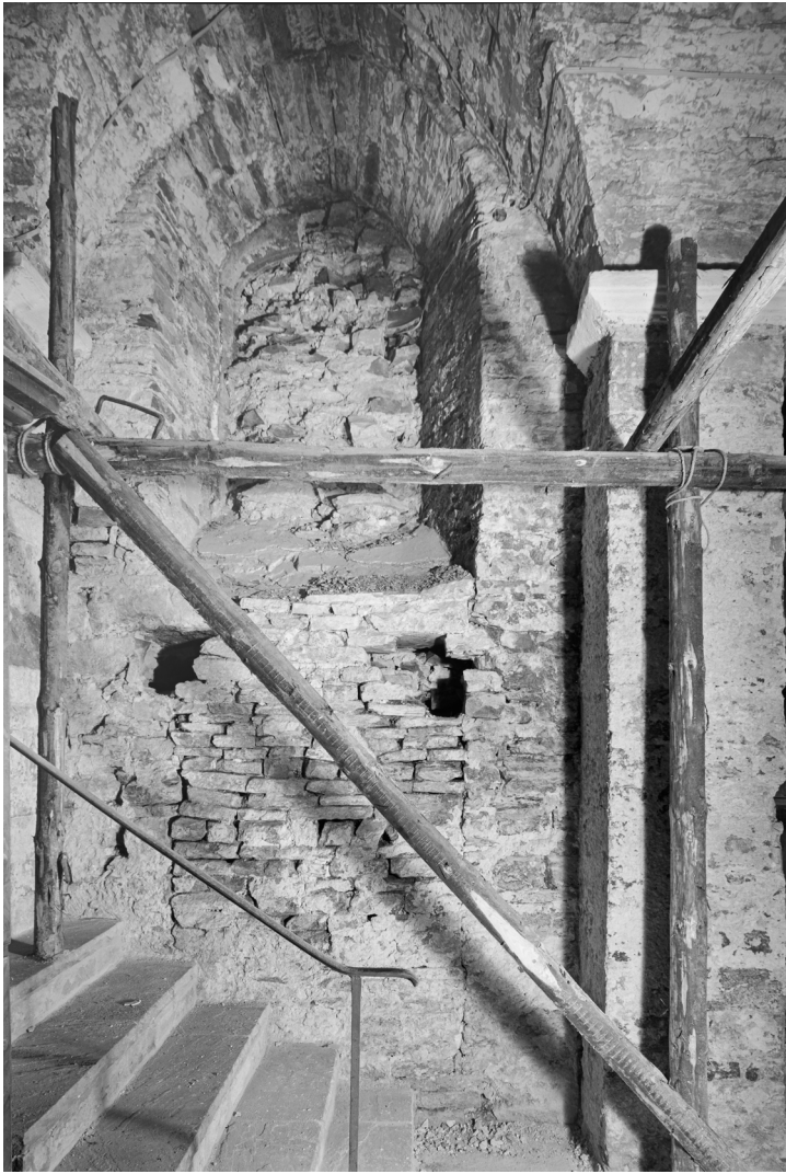
Abb. 886 Erdgeschoss, Westjoch des Nordseitenschiffs. Vorlagen der Einwölbung um 1600 und Nordwand ohne Putz während der Restaurierungen der 1950er Jahre. Der am linken Bildrand nur teilweise sichtbare Steinverband der nordwestlichen Eckvorlage scheint auf Farbwechsel hinzudeuten, entsprechend der gegenüberliegenden älteren Wandvorlage in der Südwestecke.
