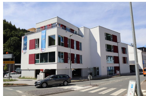
LWL-Tagesklinik Plettenberg, Außenstelle der LWL-Klinik Hemer
